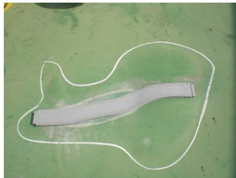
ガス検知箇所のコーキング処理 & 注入範囲
