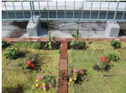
(a)2008年5月28日 屋上緑化施工当日
