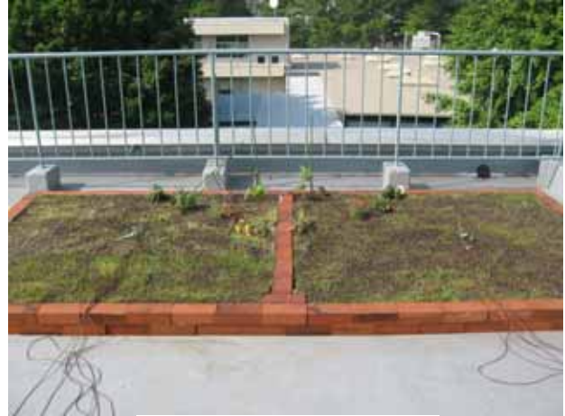
図1 屋上緑化区画全体写真
