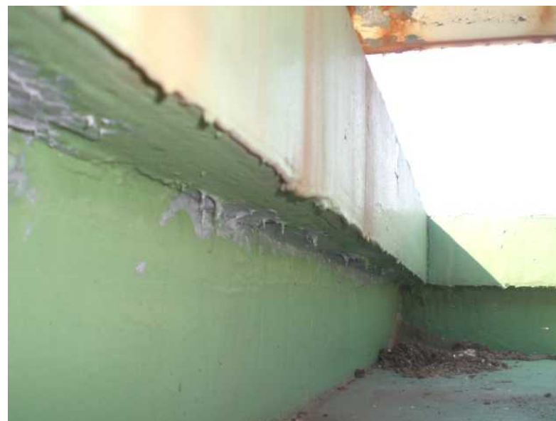
ガス検知箇所のコーキング処理
